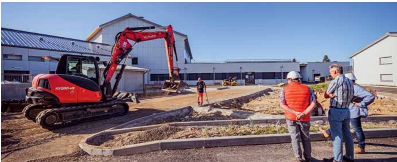
La fin de chantier est prévue en 2026 au collège des Côtes à Péronnas
